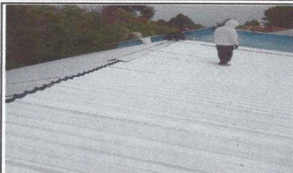
Foto 2: Instalación de capote para lámina troquelada aluzinc
