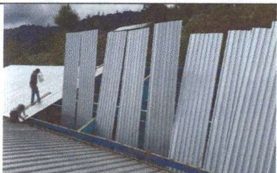
Foto 3: Sustitución de elementos de fijación (tornillos)
