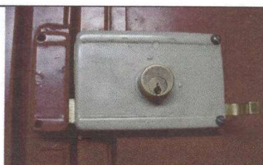
Foto 6: Sustitución de chapa marca Yale en una puerta de un aula
