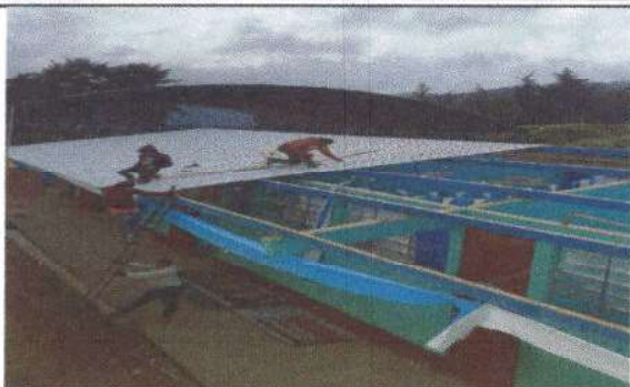
Foto1: Instalación de lámina troquelada aluzinc c 26 (0.40 mm=
